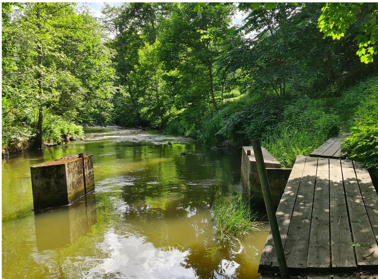
Figur 12. Grunddammen i Sigtunaån, nedströms Frösjön. Foto: Elin Nyström Hult, Norconsult 2022-06-27.
