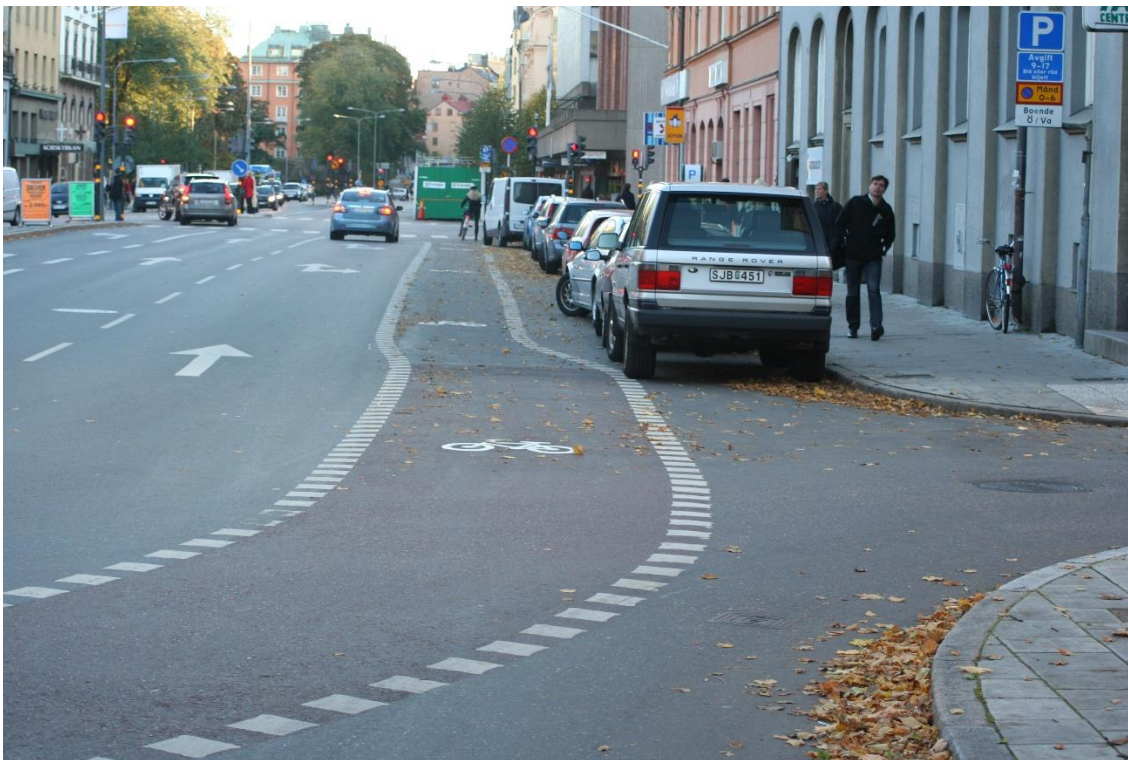
Figur 3-9 Säkerhetsavstånd mellan cykelfält och parkerade bilar. Foto: WSP
