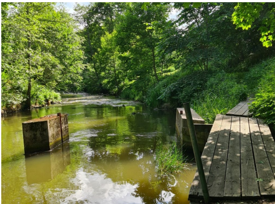
Figur 5-6 Grunddammen i Sigtunaån, nedströms Frösjön. Foto: Elin Nyström Hult, Norconsult 2022-06-27.
