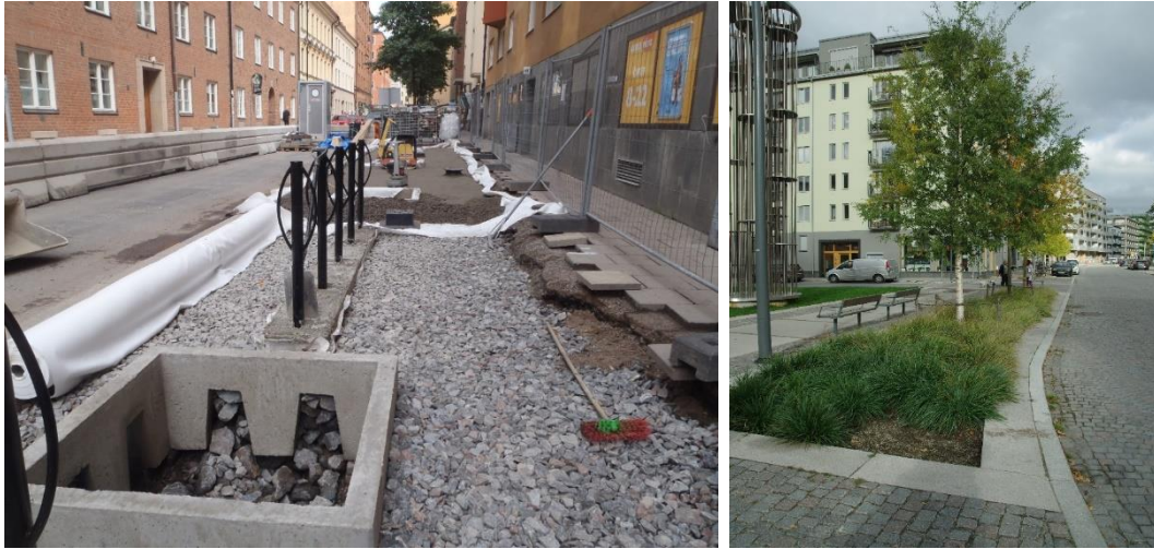
Figur 13. Till vänster: Exempel på etablering av skelettjord i befintlig miljö i Stockholm. Foto: Björn Embrén, Trafikkontoret Stockholm. Till höger: Exempel på träd i skelettjord. Foto: WRS AB.
