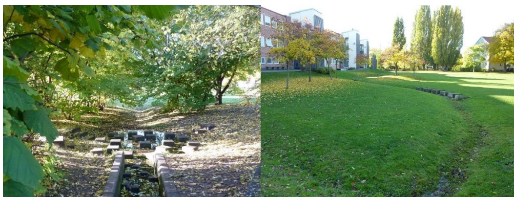
Figur 12. Exempel på utformning av en torr damm/översvämningsbar yta. Foto: WRS.
